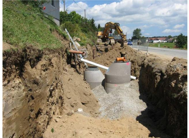
Die Abwassergenossenschaft Kleinpertholz hat neben der Errichtung des Abwasserkanals auch die Leitungen der Wasserversorgung und den bestehenden Regenwasserkanal erneuert.
