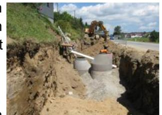
Im Zuge dieser Arbeiten wurden die EVN-Kabel und die Ortsbeleuchtungskabel in die Erde verlegt und die Ortsbeleuchtungen mit LED Lampen ausgestattet.
